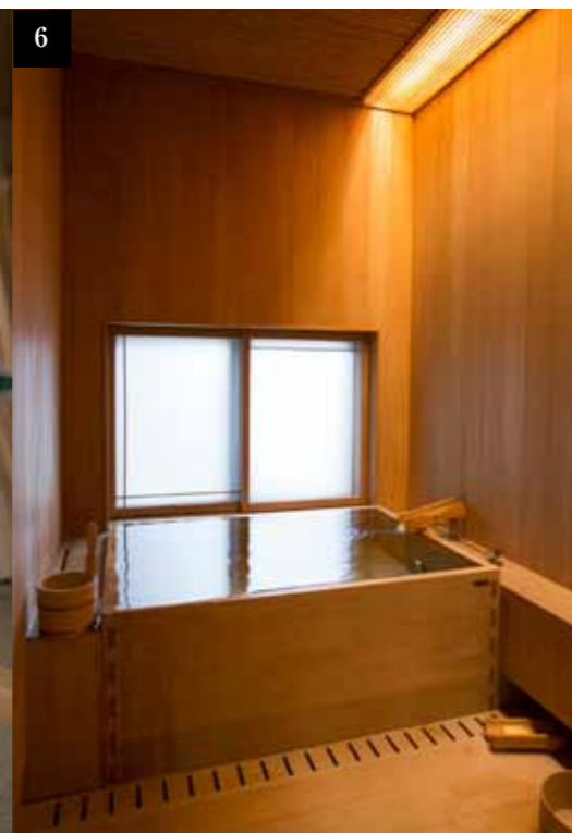
6 木風呂を乾かすために、浴槽の周囲に隙間を設ける。木は完全に水に浸かっているか、すっかり乾いていると、長持ちする。
