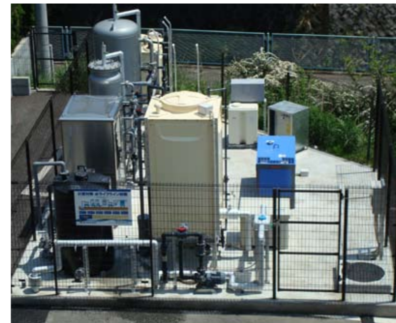
膜ろ過システム設置例（医療法人社団総生会 麻生総合病院）
