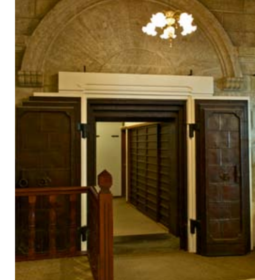
L'entrée du Kinsenro, vue du hall de réception. La combinaison des magnifiques arches en tuffeau et des lourdes portes métalliques pare-feu accroche l'œil.
